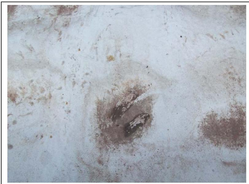
Bild 7: Eine einzelne trockenliegende Pfütze mit erstem Rotalgenbefall
