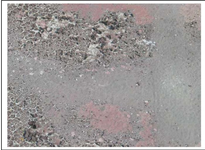
Bild 10: Aufbruch der Oberfläche nach einem Rotalgenbefall
