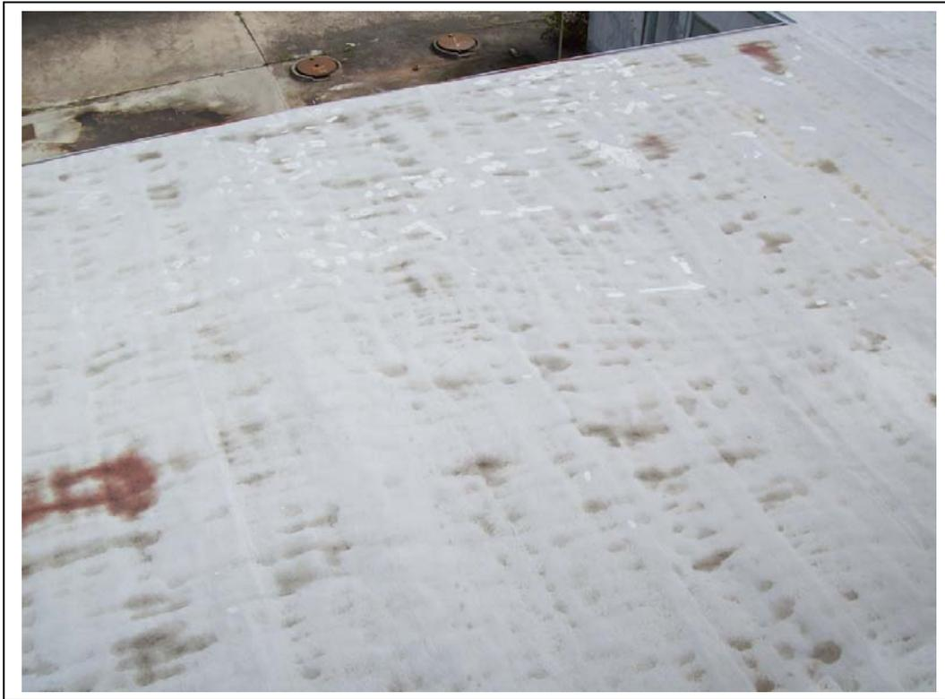
Bild 2: Erste Anfänge eines Rotalgenbefalls
