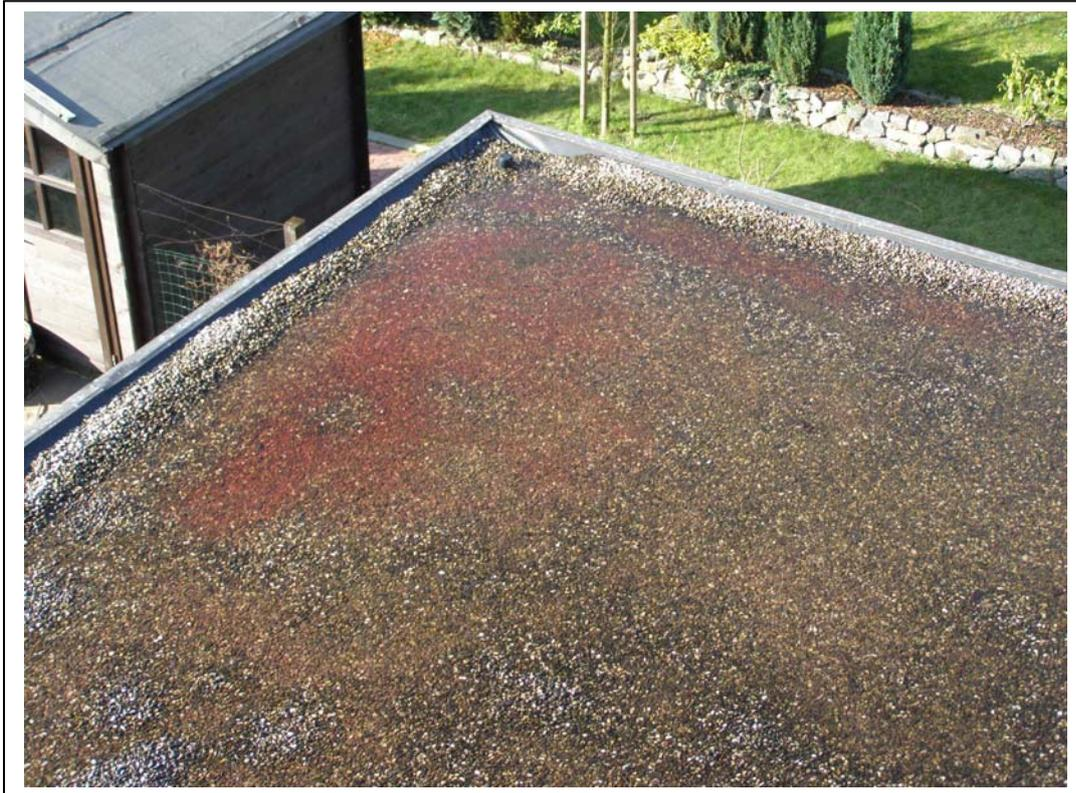
Bild 5: Rotalgenbefall auf einem bekliesten Garagendach
