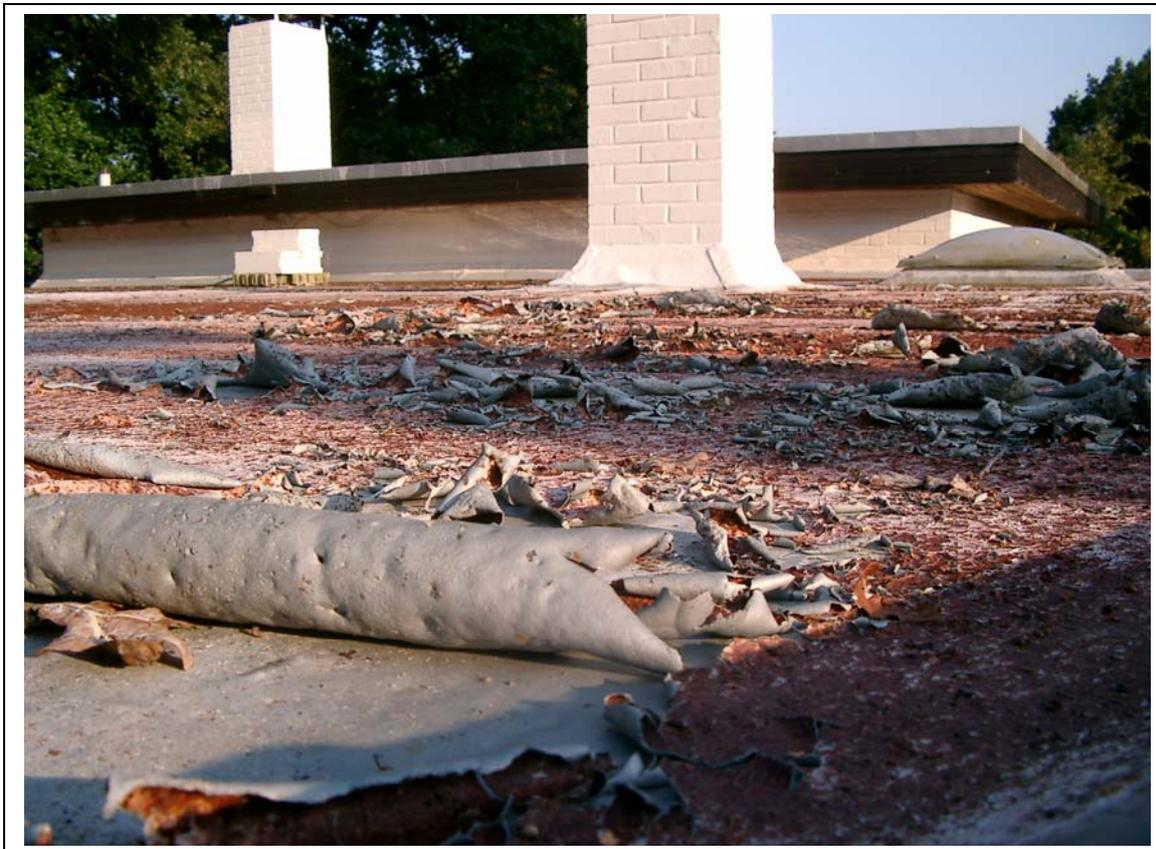
Bild 1: Völlig zerstörte Oberfläche auf einem Flachdach, der Untergrund löst sich und rollt sich stellenweise großflächig auf.
