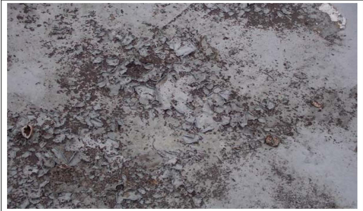
Bild 3: Fortgeschrittener Algenangriff in einer trockenen „Pfütze“. Die Oberfläche löst sich ab und beginnt sich langsam aufzurollen. Die Oberfläche sieht dann aus wie welkes Laub.
