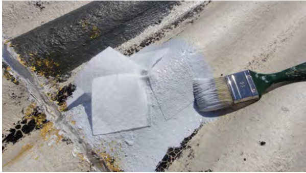
Die Plattenübergänge und die Längsrisse werden mit Vliesstreifen überdeckt
