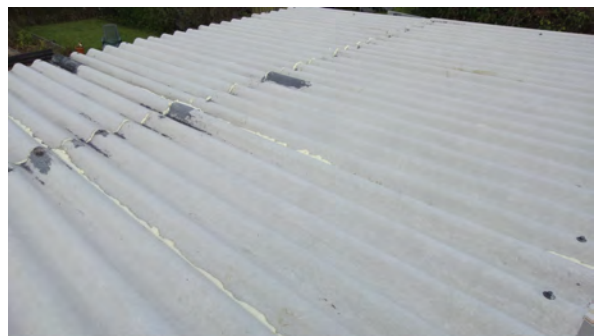
Schritt 2: Ausschäumen der Fehlstellen und Plattenfugen
