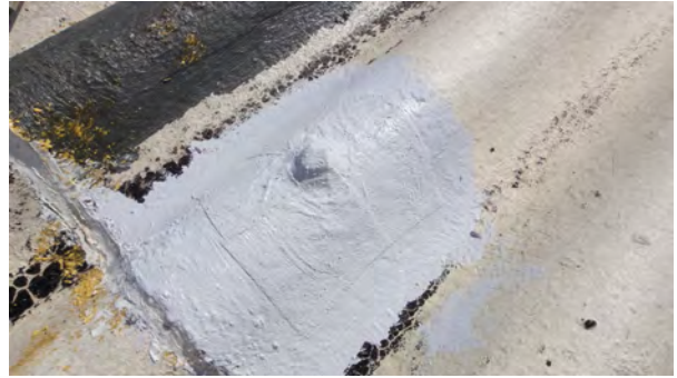
Die Plattenübergänge und die Längsrisse werden mit Vliesstreifen überdeckt
